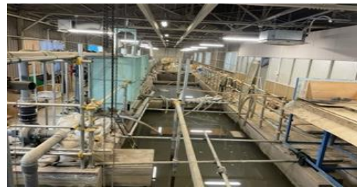
【写真2】 第3 実験棟内
